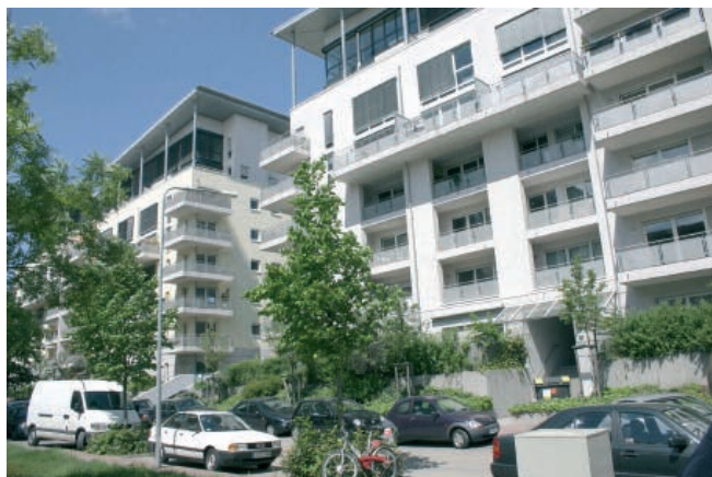
Bild 1 • Frankfurter Wohnanlage Athlon-Place mit 450 Wohneinheiten
